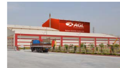
AGL Dapur Plant (Wall Tiles)
